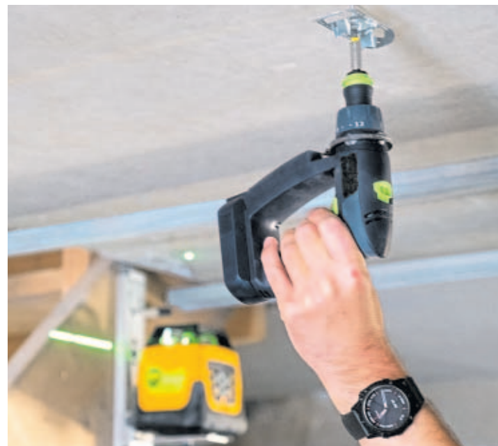
Der Nivellier-Laser im Hintergrund gibt die Höhe vor. Sobald der Prototyp des Schraubers die Position erreicht hat, stoppt er automatisch
