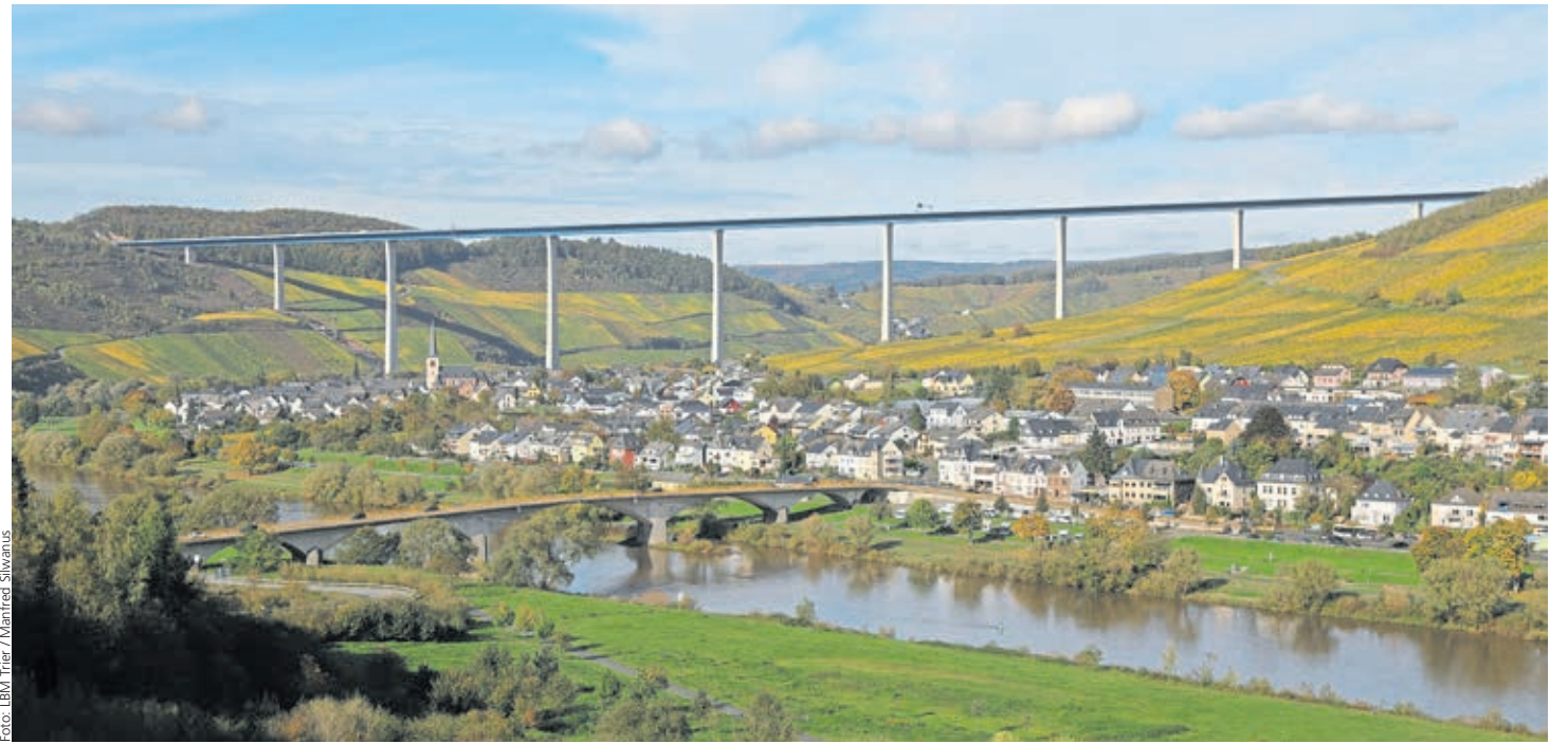
Die Hochmoselbrücke noch vor ihrer endgültigen Fertigstellung
