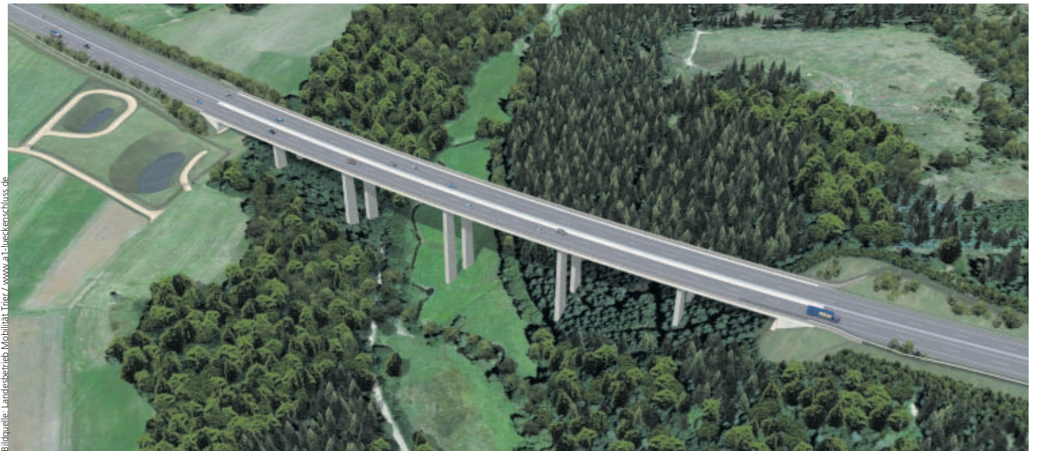
Oben: Auf der Internetseite a1-lueckenschluss.de des Landesbetriebs Mobilität kann man die geplante Strecke virtuell nachfahren. Unten: Insgesamt 43 Brückenbauwerke wie die Talbrücke Nohner Bach Nord (3D-Modell) wären für den Lückenschluss notwendig
