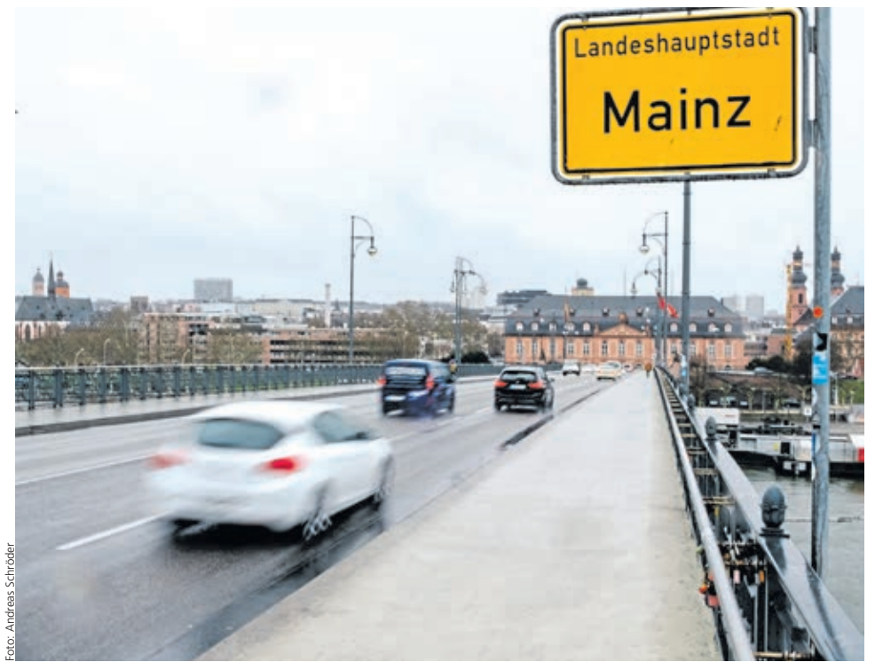
Pendeln über den Rhein: die Theodor-Heuss-Brücke in Mainz
