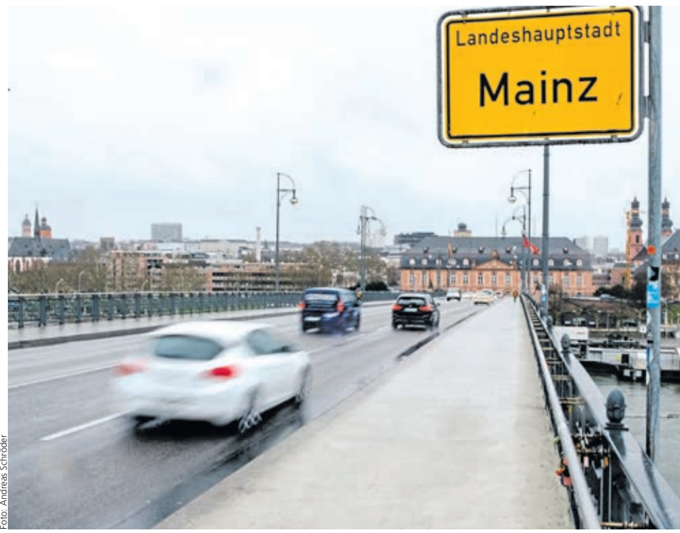
Pendeln über den Rhein: die Theodor-Heuss-Brücke in Mainz
